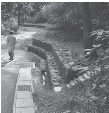
県が実施した蒲の沢対策工事
